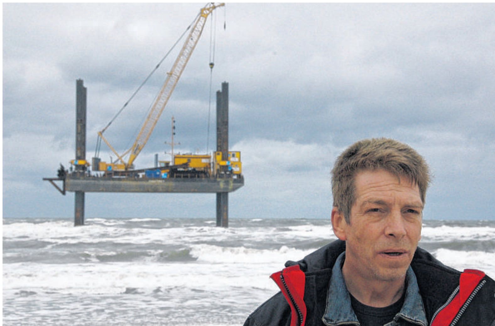
Ponton vor Norderney: Mit seiner Moll-prd GmbH setzt Günter Moll millionenschwere Projekte etwa für die großen Energieversorger um.
